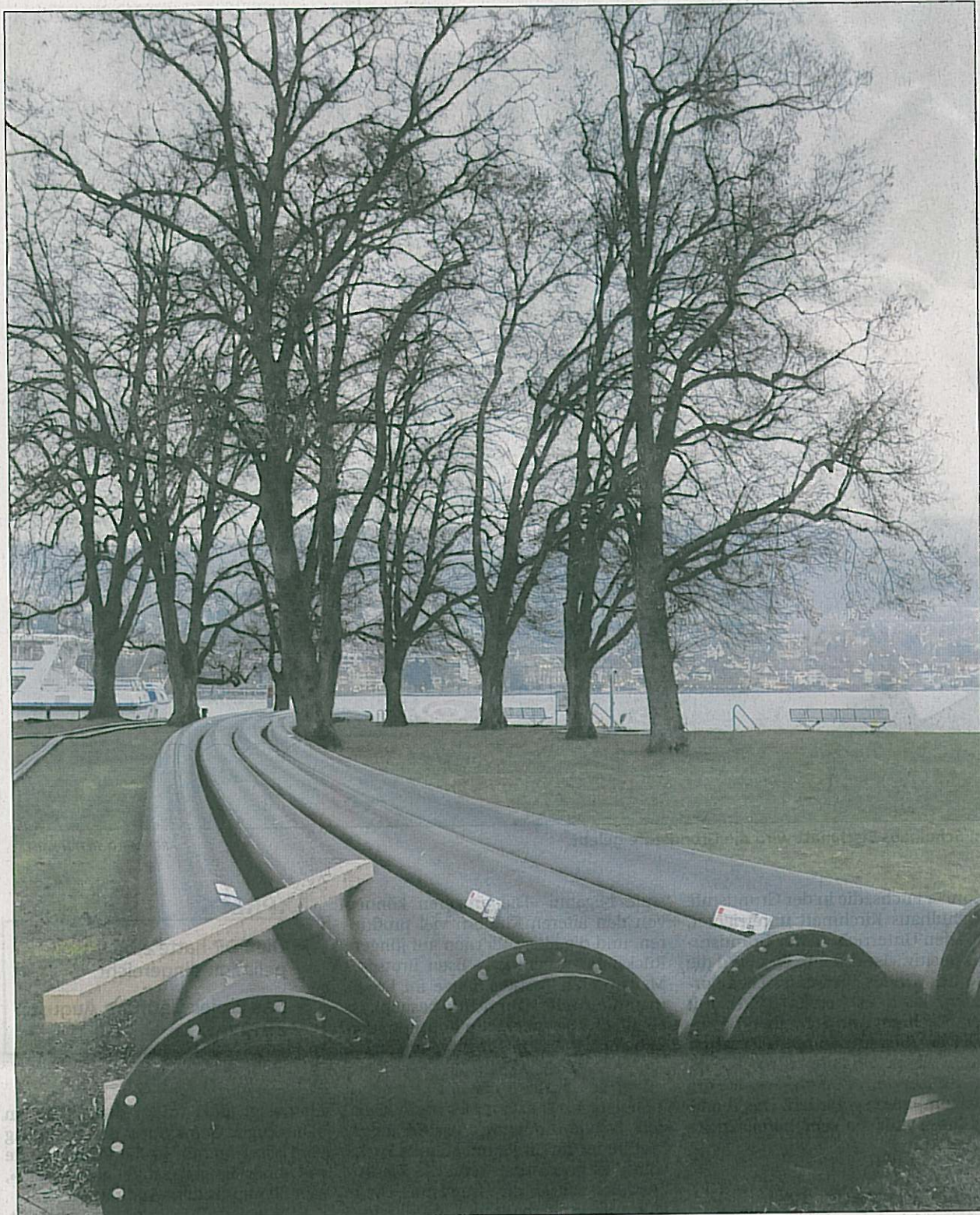
Noch liegen die Rohre in der ehemaligen «Männerbadi». Doch schon bald werden sie auf den Grund des Zugersees verlegt.
