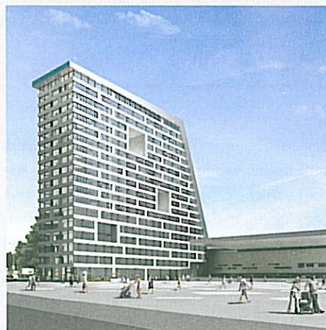
«Uptown», das scheibenförmige Hochhaus in Zug, ist eine nachhaltige architektonische Perle.
