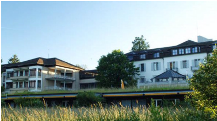
440 Tonnen CO2 weniger: Das neue Spital Männedorf.
