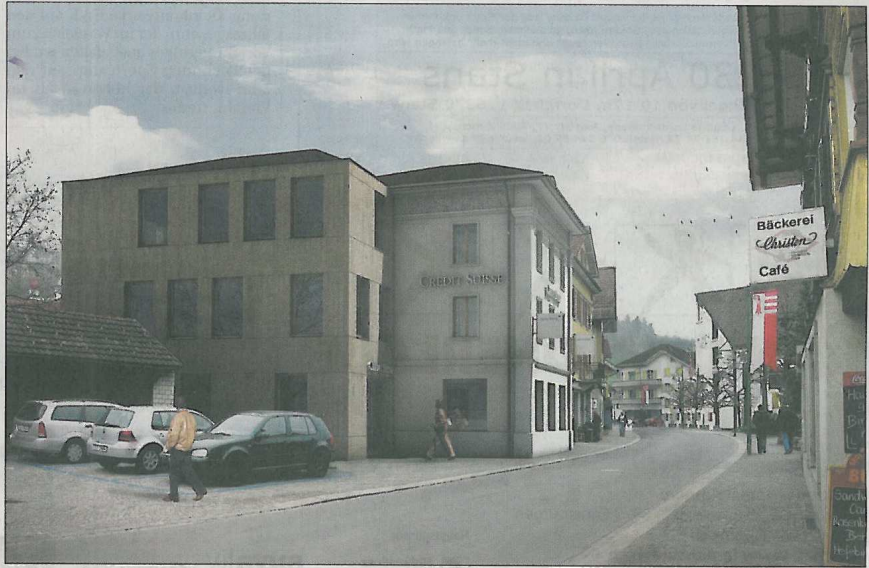
So präsentiert sich ab Mai 2011 die neue Geschäftsstelle der Credit Suisse an der Lindenstrasse 6 in Sarnen.
